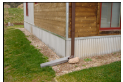
Figure 2 : Fondation à parement métallique
